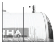
B5: Lắp đường nước vào phía trên thân bồn
